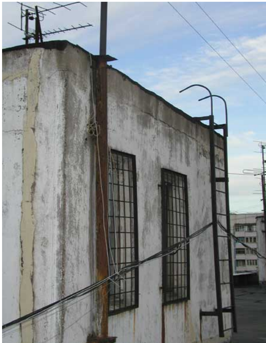
Рис. 2.20. Прокладка по крыше.
