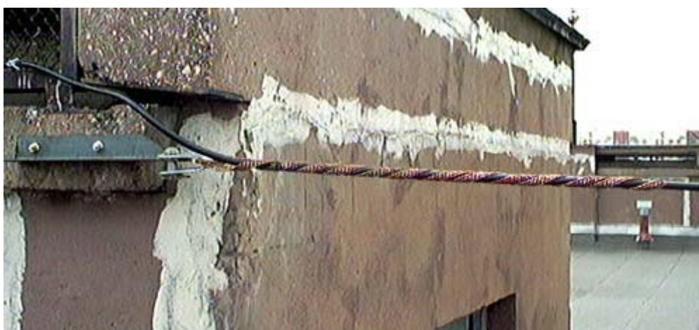
Рис. 1.52. Крепление при помощи спирального зажима.
