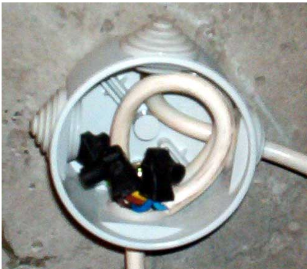
Рис. 2.2. Соединение силового кабеля.
