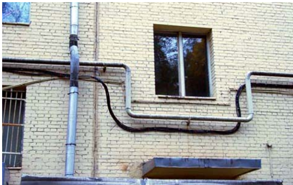
Рис. 1.40. Прокладка кабеля по стене.
