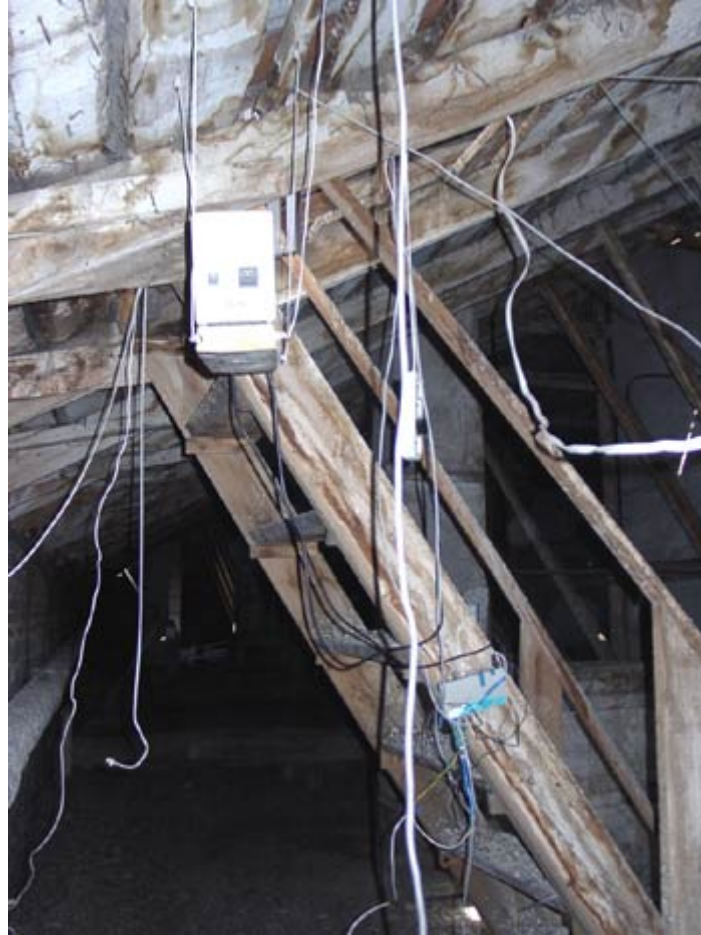
Рис. 2.5. Установка на чердаке.
