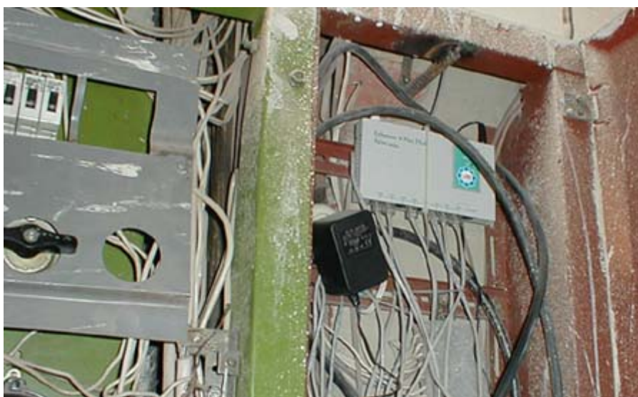
Рис. 2.7. Установка в электрощитке.
