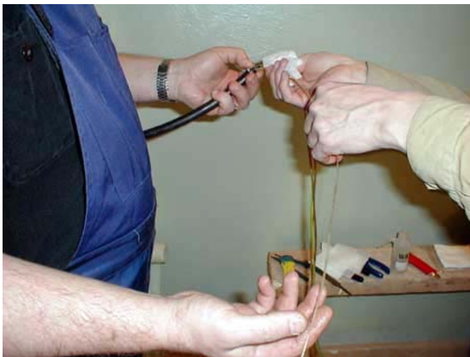
Рис. 3.3. Кабель со снятой внешней оболочкой.
