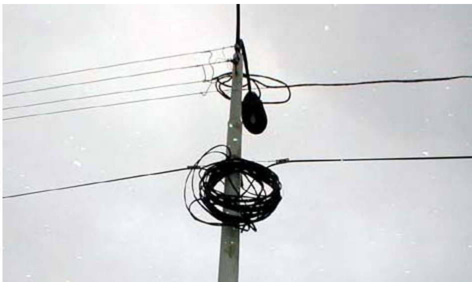
Рис. 1.39. Остатки кабеля после натяжения.
