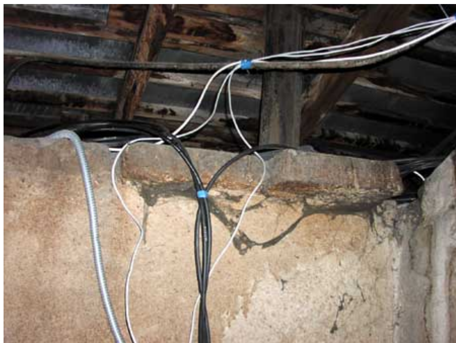
Рис. 2.21. Прокладка по чердаку.
