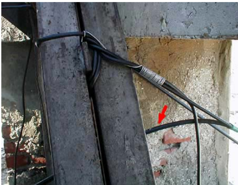
Рис. 1.51. Крепление несущего троса кабеля-восьмерки.
