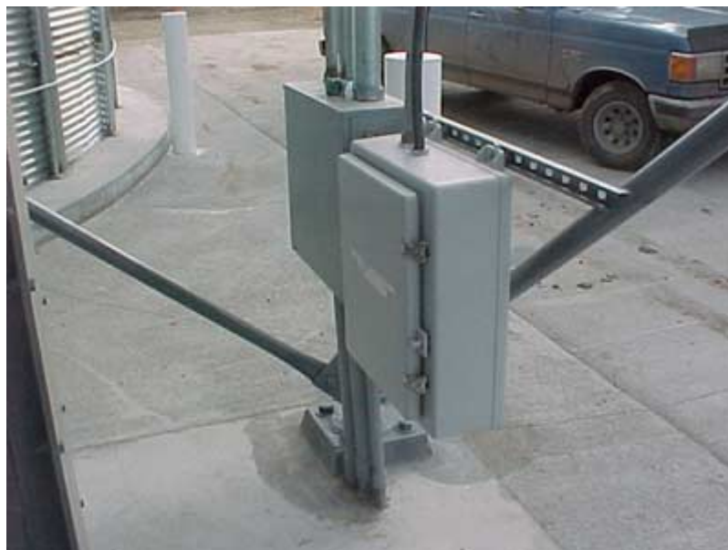
Рис. 2.9. Установка на улице.
