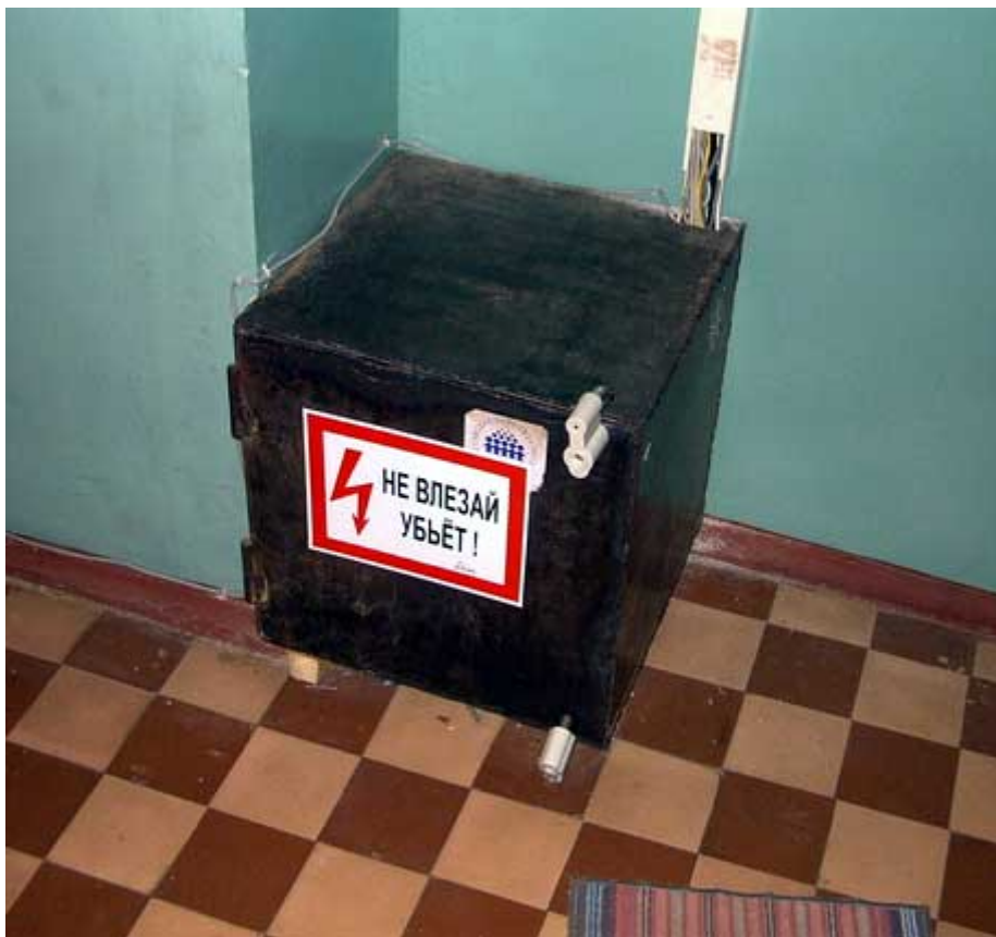
Рис. 2.6. Установка в подъезде.
