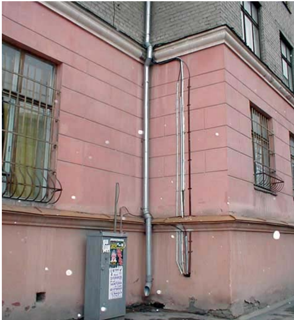
Рис. 1.41. Спуск кабеля по стене.
