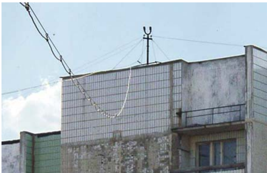
Рис. 1.48. Вид линии после перетяжки кабеля.
