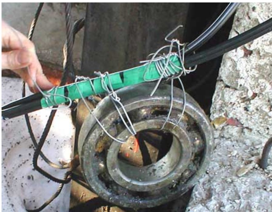
Рис. 1.34. Изготовление петли.
